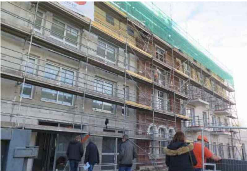
Le chantier avance au rythme prévu, les locataires pourront emménager dès le mois de juillet 2019.
